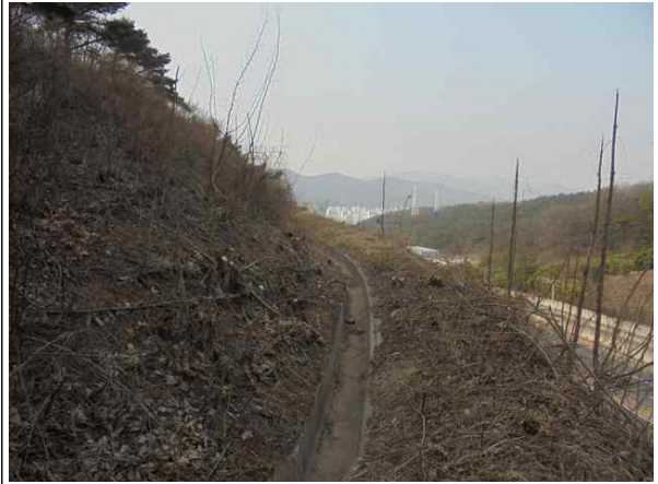
2소단 배수로 전경
