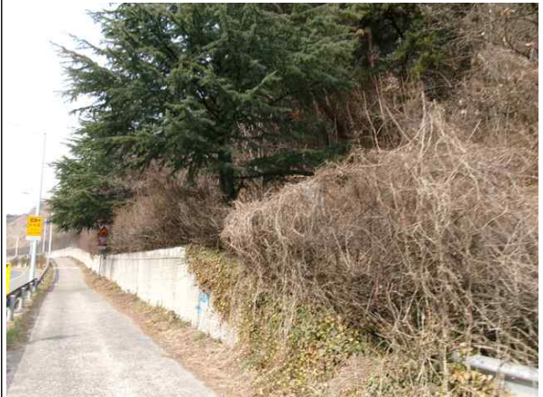
낙석방지울타리 및 하부 전경
