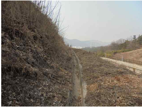
1소단 배수로 전경
